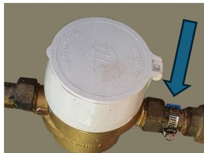
(Nel caso sia collegato direttamente alla doccia, è preferibile che anche il cavo flessibile sia metallico). Dopo averlo messo attorno al tubo, si serra l'anello avvitando nuovamente la vite.
